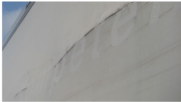
↻ Fiancate in fibra: deformazione nella parte inferiore, lunghezza > 1 m Nota: la sostituzione del pannello anteriore nel sottoscocca richiede lo stacco di quest'ultimo.
